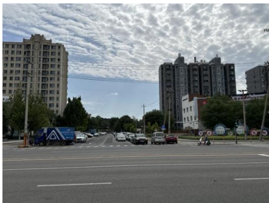
照片 2-7 田村片区-道路
