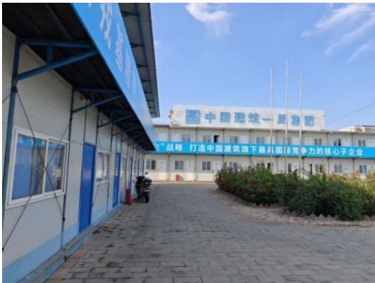
照片 2-15 常青片区-临时建筑
