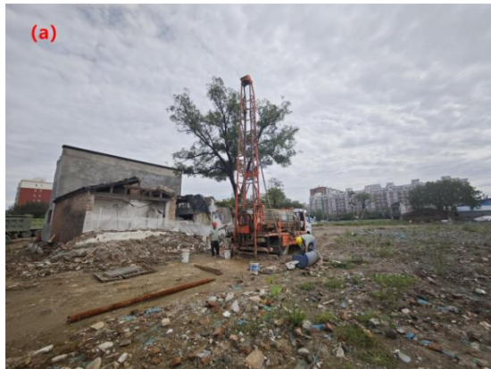
照片 1-10 施工设备 a: DPP-100 钻机
